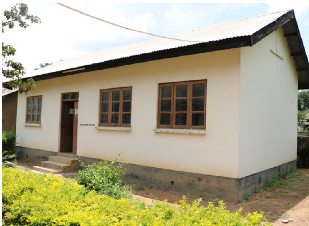
Mwonekano wa jengo la ofisi za sasa za Tume ya Utumishi wa Walimu (TSC), Wilaya ya Singida.
